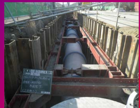
写真：若松第1排水区雨水管布設工事（1工区）
