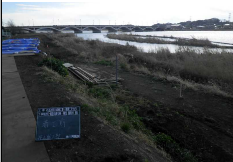
No.13付近の押さえ盛土着工前
