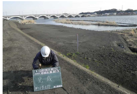
No.13付近の押さえ盛土完成
